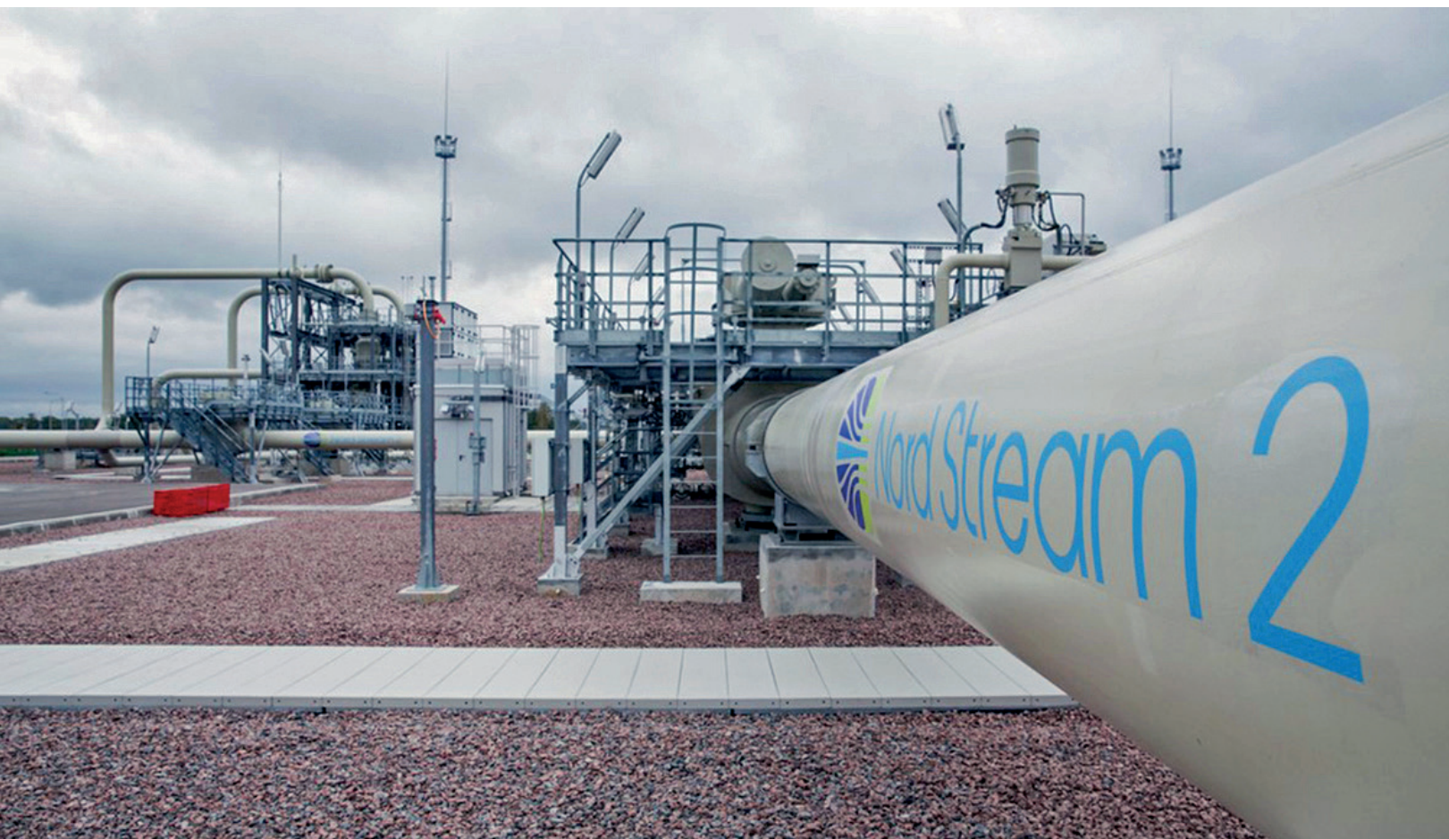
Газопровод «Северный поток-2»
